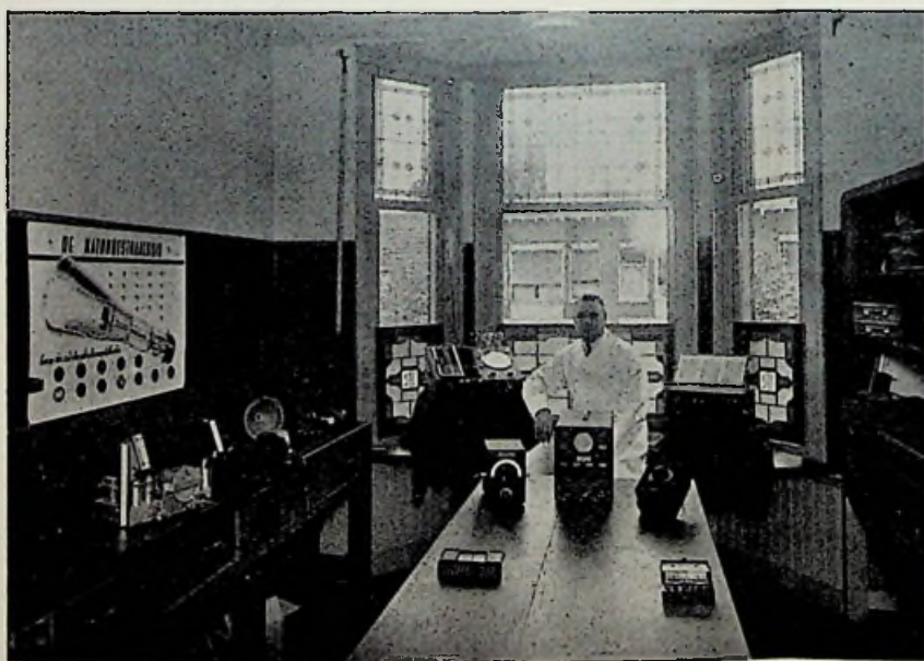
Fig. 2. De leerlingen radiotechnicus, radioservicetechnicus en radiomonteur behooren vertrouwd te zijn met de op een radio-werkplaats of laboratorium gebezigde meetinstrumenten. Vooral de kathodestraal-oscillograaf (midden) is een bij uitstek geschikt instrument om allerlei elektrische verschijnselen zichtbaar te maken. We zien hier den Heer Oosterwijk te midden van zijn attributen.
