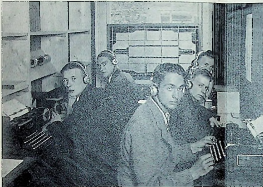
Fig. 1. Voor de praktische vorming is het noodzakelijk, dat de radiotelegrafisten met het scheepsverkeer vertrouwd raken. Aan de in deze afdeling geplaatste ontvangtoestellen, waarbij ook een decametergolfontvanger, wordt de practijk beluisterd en worden de roepnamen der met elkaar corresponderende stations in een dagboek genoteerd. Tevens is in deze ruimte plaats voor twee, met elkaar werkende radiotelegrafisten, die onderling telegrammen wisselen, zooals dit in de practijk geschiedt. Het opnemen kan ook met de schrijfmachine geschieden.
